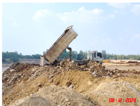
รูปที่ 3 การถมกลับพื้นที่ที่ผ่านการทำเหมือง
